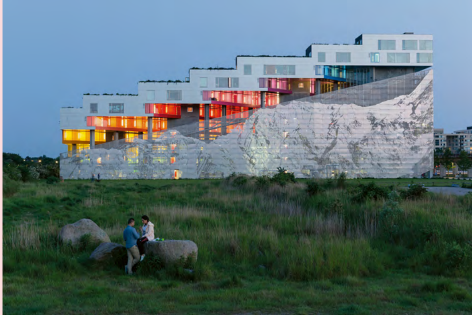
Das Parkhaus ist umrahmt von einer Lochblechfassade mit Gebirgsmotiv.
