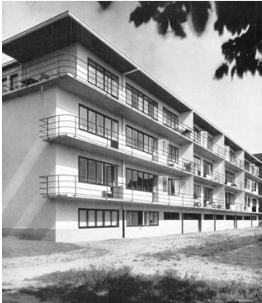
Bernhard Hermkes: Wohnblock Adickesallee, Frankfurt am Main, 1930.
