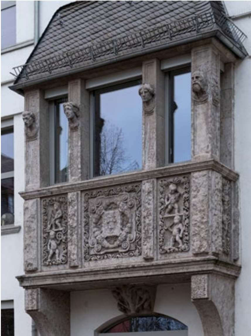
Karl Huber: Erker am Direktorenzimmer der Technischen Lehranstalten, heutiger Zustand.
