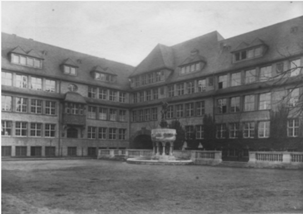
Hugo Eberhardt: Neubau der Technischen Lehranstalten Offenbach, 1911–1913, Ansicht vom Schlossplatz.
