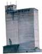
6 Getreidesilo in Feldbach
