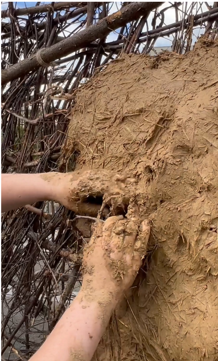
Den Lehm auftragen & anbringen. Applying & attaching the clay.
