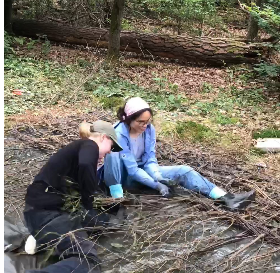
Frische & biegsamere Junghölzer wurden direkt vor Ort zu Wandelementen verarbeitet Fresh & flexible young woods were shaped on-site into wall elements.
