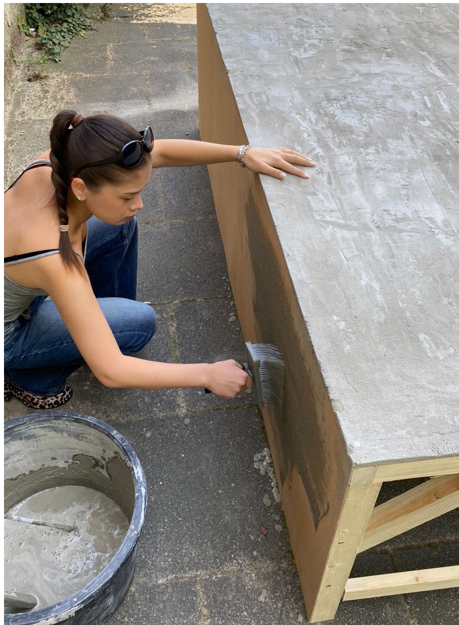
Aufgeschraubte Holzplatten werden mit Beton bestrichen, so entsteht der massive "Look" Screwed wooden panels are coated with concrete, creating the massive "look"
