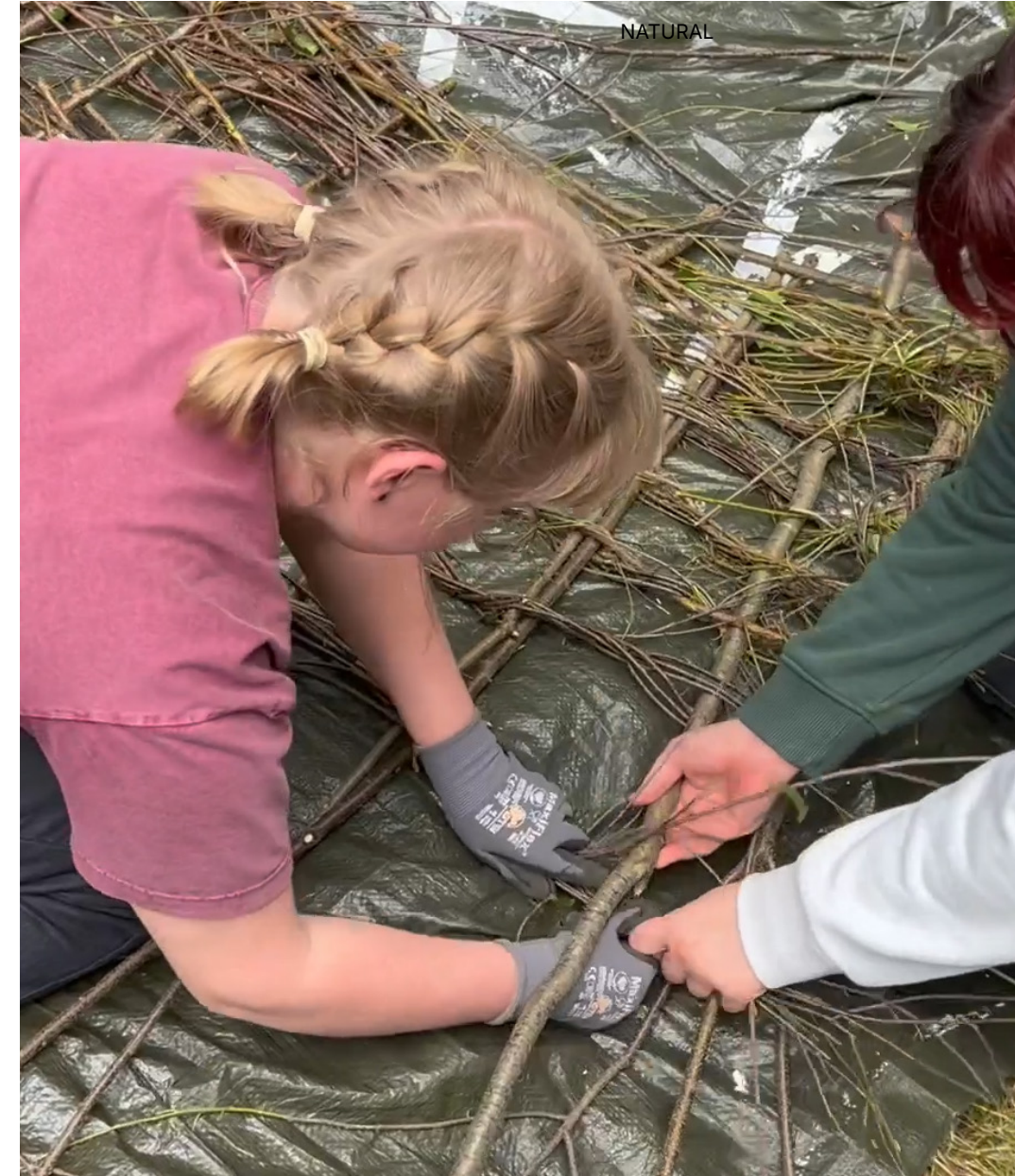
Die Wandelemente werden geflochten The wall elements are being woven
